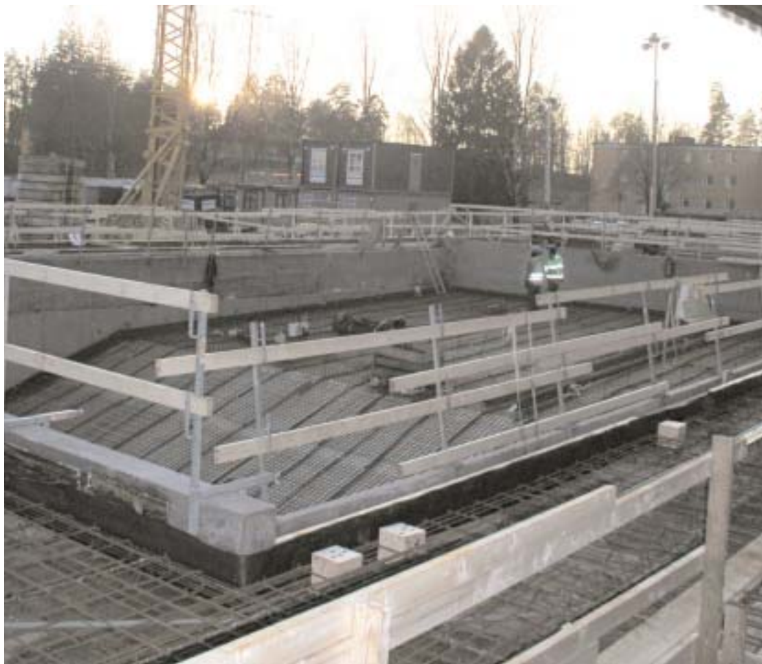
Nu är man klar att gjuta bassänggolvet i den stora bassängen. Armeringen är rikligt tilltagen för att hålla för trycket när vattenmassorna fylls på. Innan jul hoppas man att gjutningen skall vara klar så man kan fortsätta med att få det hela under tak innan vintern slå till på allvar.
